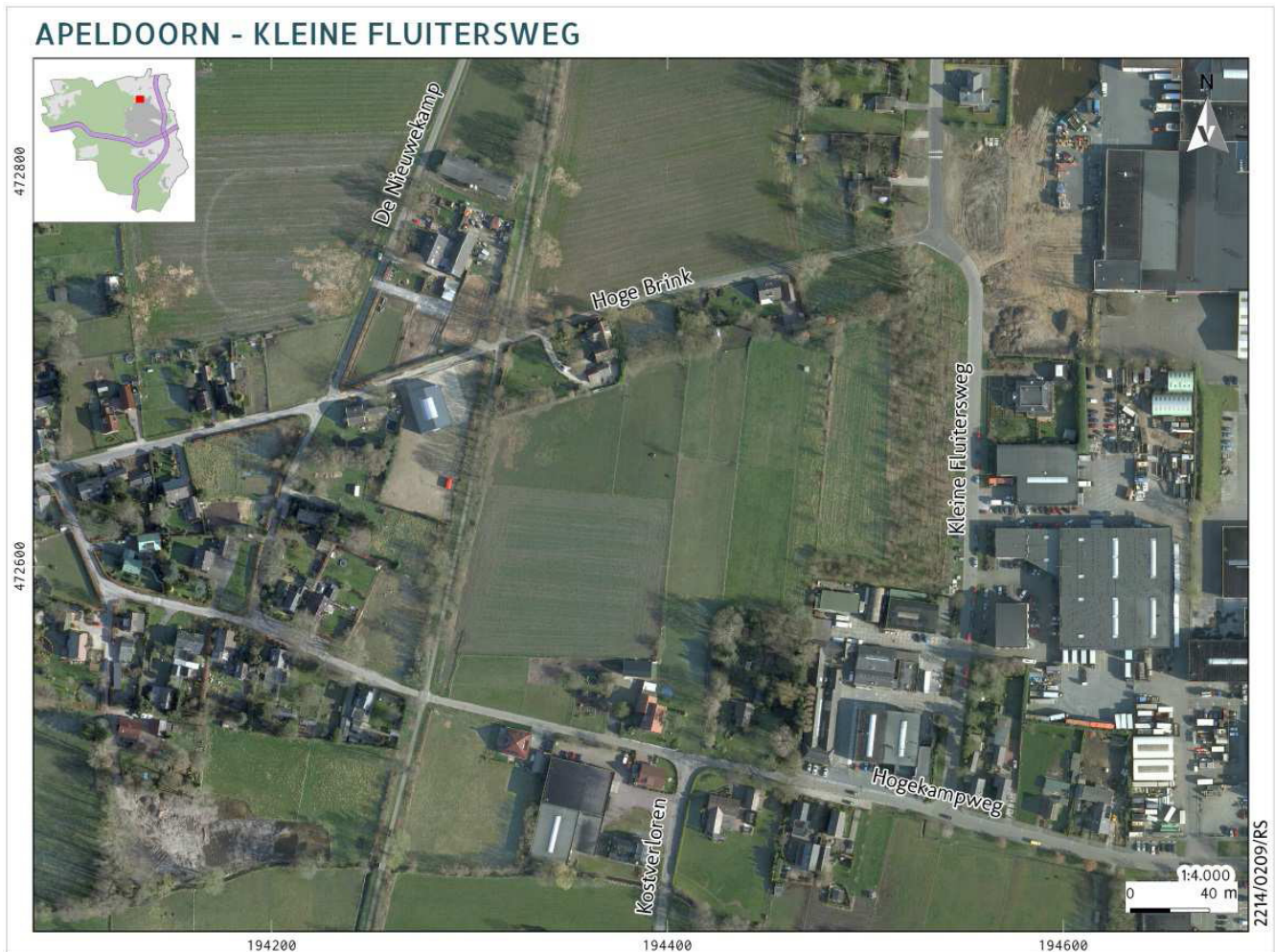
Afbeelding 2-2 Wenum-Kleine Fluitersweg. Luchtfoto met de huidige situatie. Bron: gemeente Apeldoorn.
